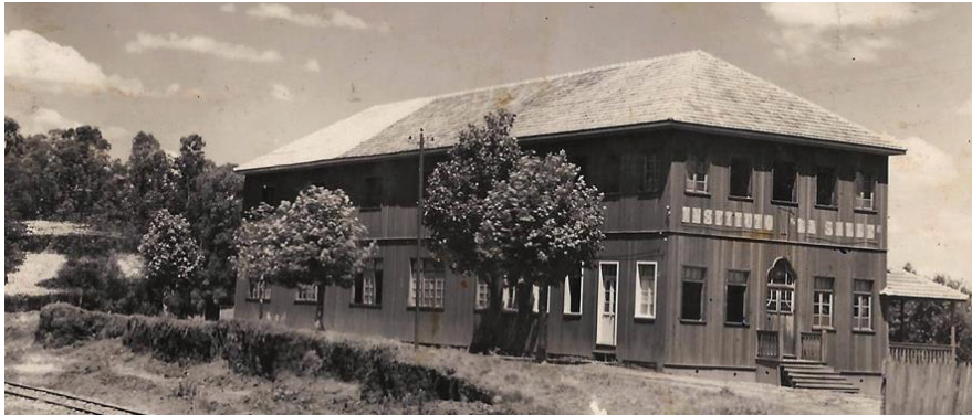
Primeiro prédio de madeira, em 1937
